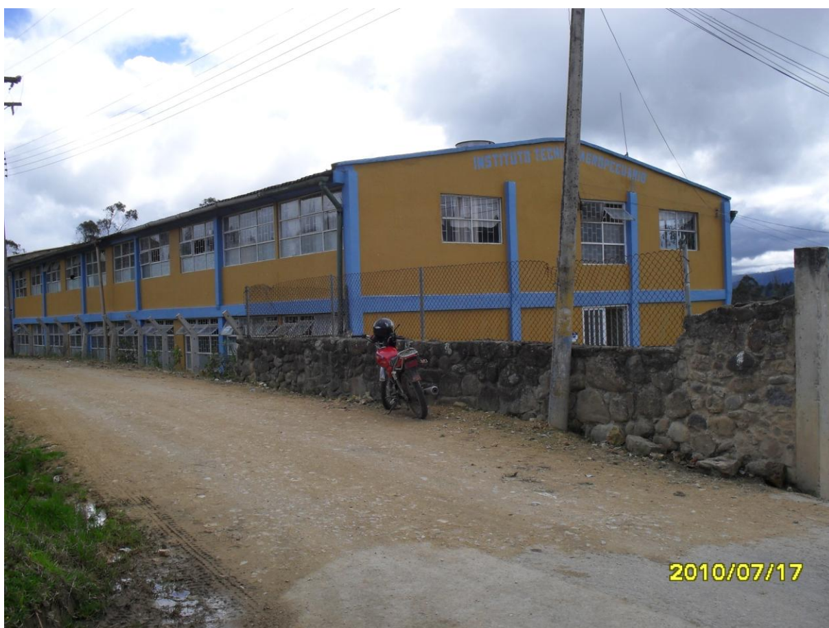
FOTO 22. VISTA GENERAL BLOQUE 1 (ADMINISTRACIÓN, LABORATORIOS Y AULAS DE CLASE)
