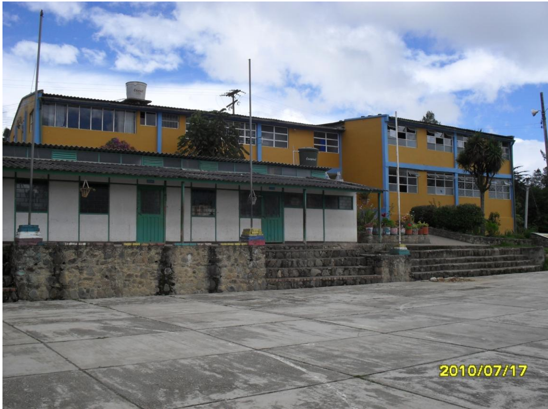
FOTO 23. CANCHA DE BALONCESTO, RESTAURANTE ESCOLAR, OFICINAS ADMINISTRATIVAS Y SALONES
